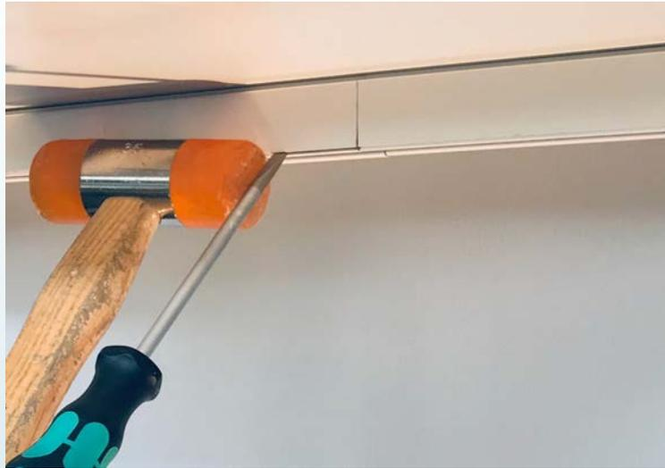
Insérer un tournevis plat dans la rainure du rail et pousser les axes avec un marteau vers l'autre rail.
